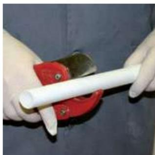
Отрезать трубу перпендикулярно ее длине, используя инструмент, который гарантирует чистый и точный срез.
