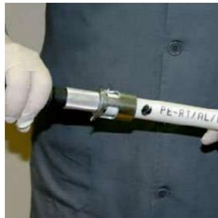
Надвигать трубу на штуцер разрешается до момента, пока пластинка с режущим краем не врежется в материал внутреннего слоя, вращая вокруг своей оси несколько раз. Штуцер приспособления должен вводиться строго вдоль оси. Любые отклонения недопустимы. Эта операция облегчает монтаж фитинга, без повреждения уплотнительных колец или их свободного перемещения.
