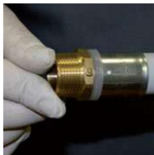
Аксессуар должен быть введен таким образом, чтобы фитинг с нержавеющей стали остался соединен с пластиковой прокладкой - электролиз.
