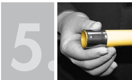
Вставьте гильзу из нержавеющей стали в трубу смотровым отверстием наружу.
