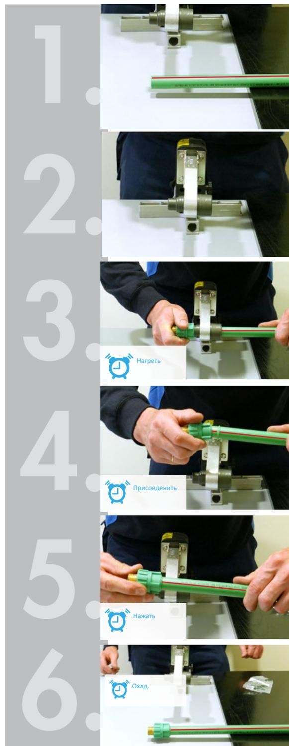
Отрезать трубу перпендикулярно ее длине, используя инструмент, который гарантирует чистый и точный срез.
