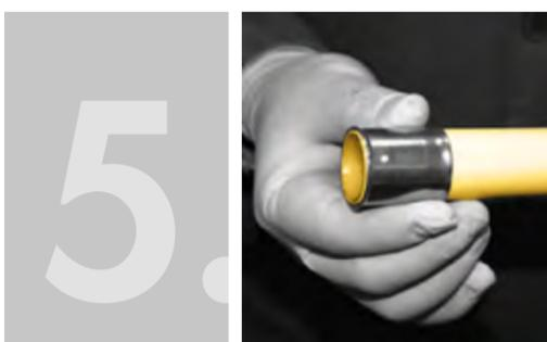
Inserir o anel de aço inox no tubo, de maneira a que os orifícios de inspeção fiquem situados no extremo do tubo.
