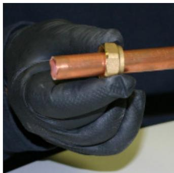
Insérez d'abord l'écrou dans le tube.
