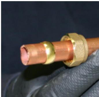
Une fois que l'écrou est inséré dans le tube, insérez la bague de retenue..
