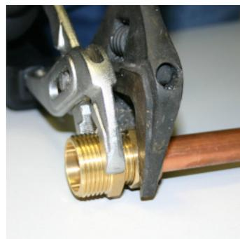
Finalement serrez l'écrou avec deux clés à molette ou clés fixes pour obtenir une pression parfaite..
