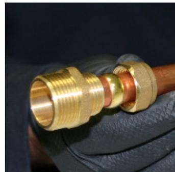
Une fois les deux pièces en place, visser l'écrou sur le corps du raccord.
