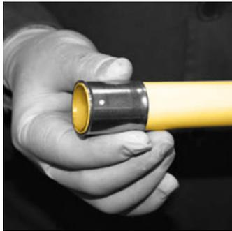
Insérez le bague en inox dans le tube, dans la position où les trous d'inspection sont situés à l'extrémité du tube.
