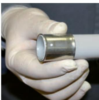
Introduire la bague en inox dans le tuyau, de façon à ce que les ouvertures d'inspection soient situées à l'extrémité du tuyau.
